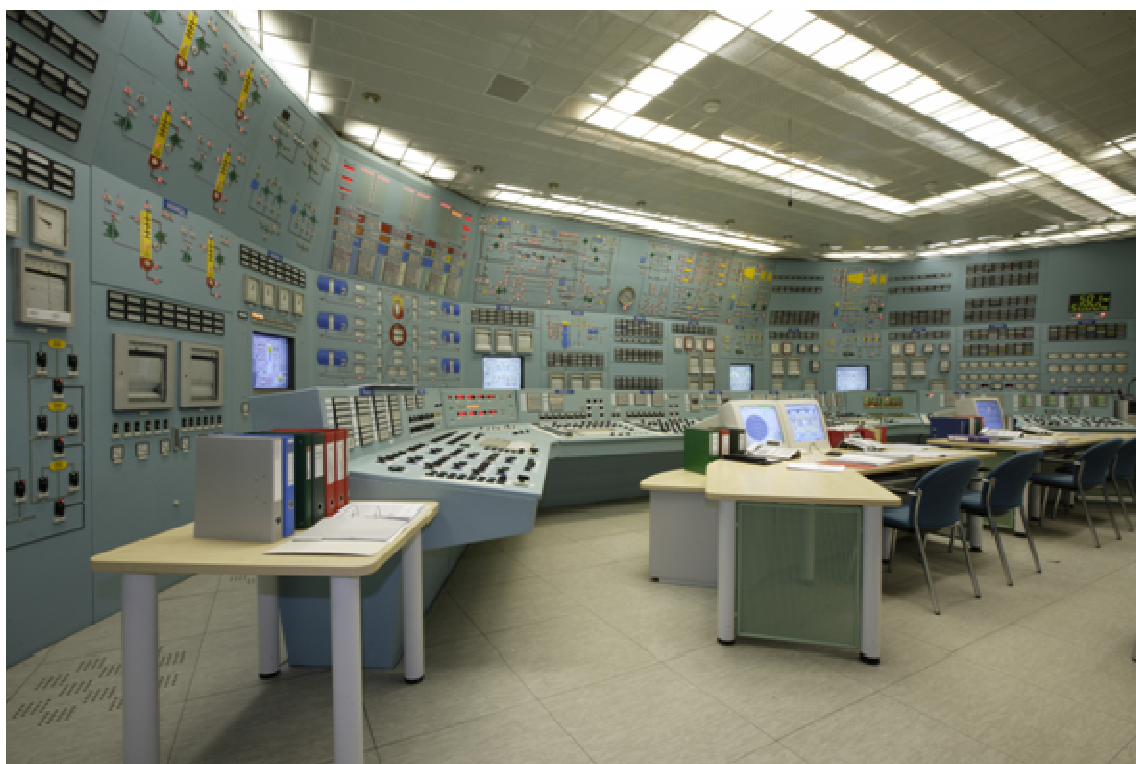
A Paksi Atomerőmű teljesléptékű szimulátorának vezénylője (© PA Zrt.)
