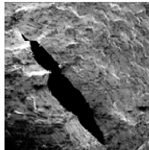
Felhasadt burkolat a felhasadás helyével
